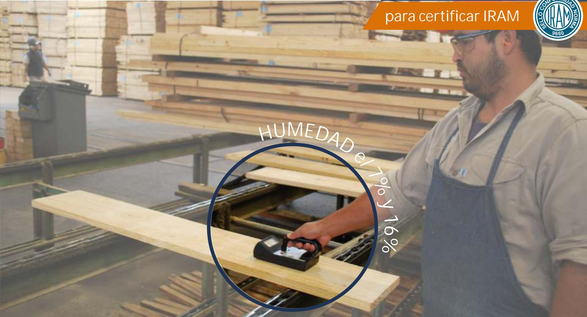
Contenido de humedad de las láminas que luego serán encoladas y prensadas debe ser el 7% a 16%
