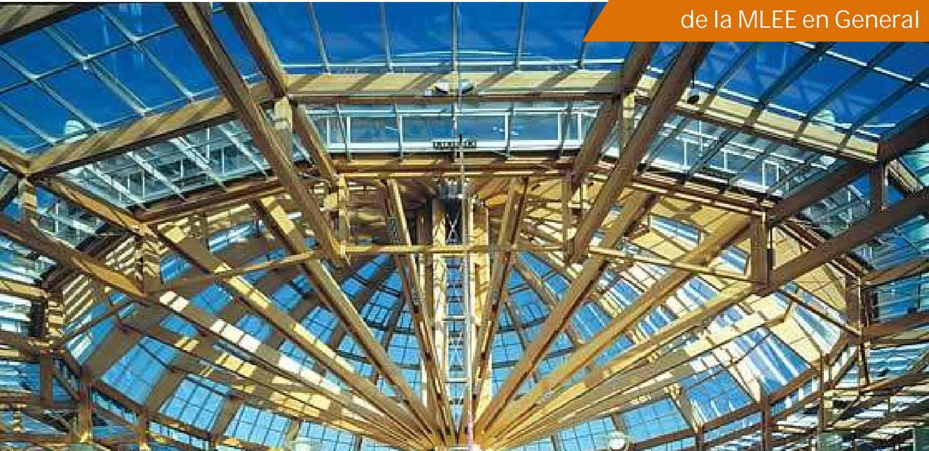
La madera laminada estructural ofrece una versatilidad sin límites para la creación arquitectónica, siendo especialmente adecuada en grandes luces que pueden superar con facilidad los 100 metros sin apoyos intermedios. Es muy resistente y liviana a la vez.
